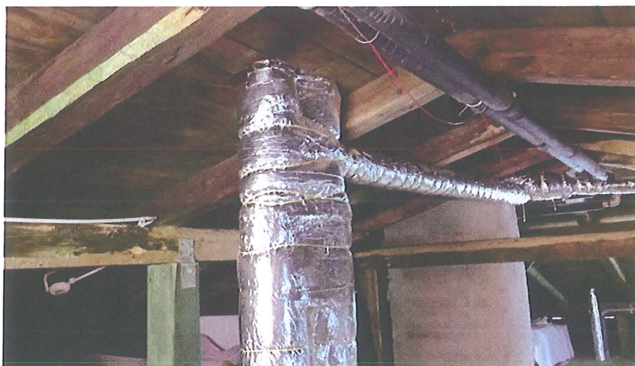
Foto nr 11. Rury odpowietrzające kanalizację fekalną w budynku.
