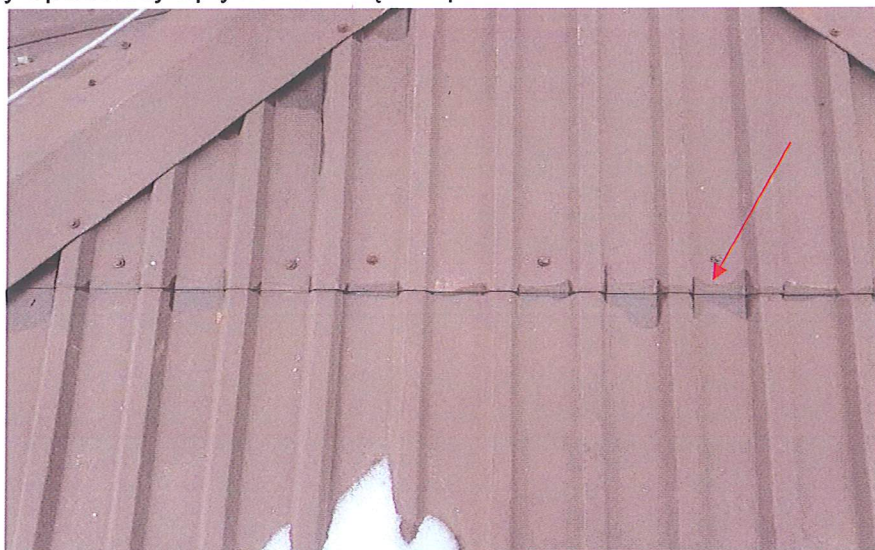
Foto nr 6. Miejsce podciągania kapilarnego w miejscu połączenia blach ( niewystarczający zakład blachy na blachę).
