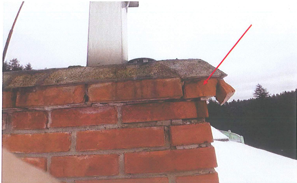
Foto nr 22. Komin z kotłowni. Uszkodzona głowica komina. Destrukcja cegieł w objętości komina. Uszkodzona pokrywa betonowa kominów.
