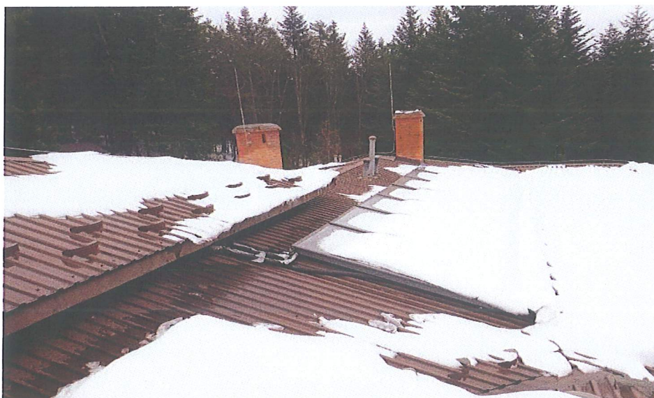
Foto nr 16. Widok dachu w stronę wschodnią. Komin y z kuchni K-2 i ze zmywalni K-3. Komin y murowane z przewodami dymowymi.
