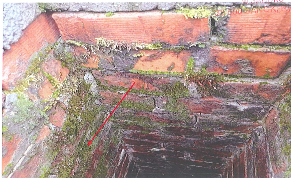
Foto nr 25. Wnętrze komina ze zmywalni ( strona wschodnia). Powierzchniowa destrukcja powierzchni cegieł i wnętrza zaprawy cementowo-wapiennej scalającej cegły. Wzrost mchu na wewnętrznej powierzchni komina.
