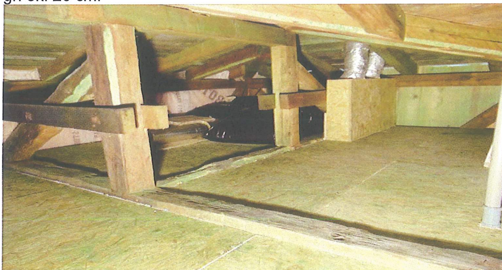
Foto nr 43. Wnętrze stropodachu. Tramy nośne wieżby dachowej.
