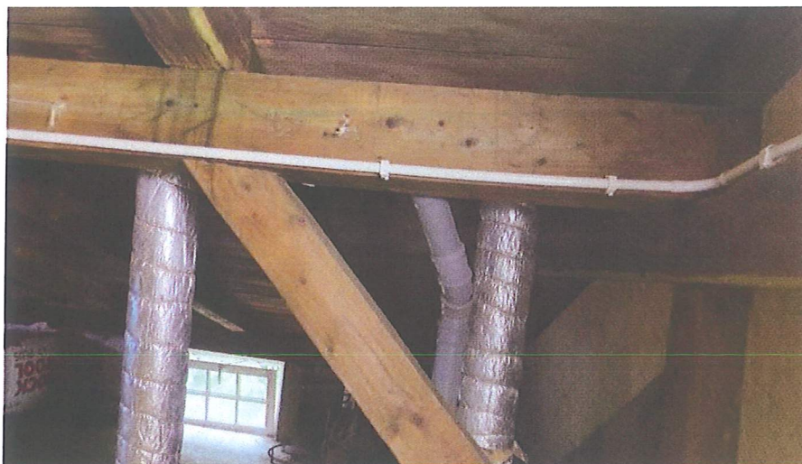
Foto nr 10. Rury odpowietrzające kanalizację fekalną w budynku.
