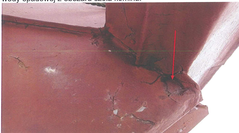
Foto nr 21. Obróbka blacharska wieżyczki sygnaturki, niedbałe połączenia wzajemne blach, uszkodzona powłoka malarska obróbki blacharskiej
