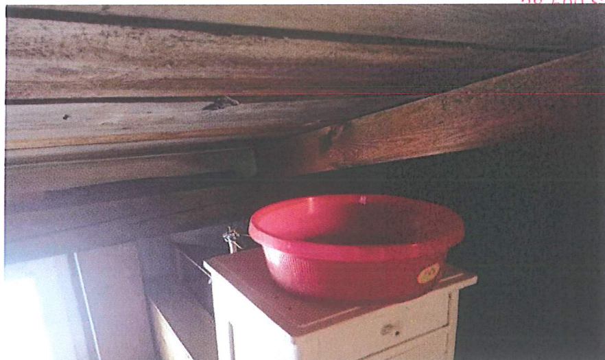
Foto nr 5. Intensywny przeciek wody przez pokrycie dachu.
