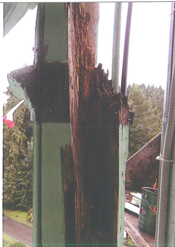
Foto nr 40. Wymiana słupka nośnego wspierającego taras.
