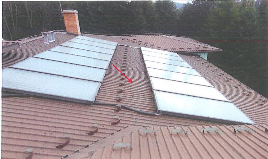
Foto nr 7. Fotografia dachu wykonana w 03.2019 r. Widok w kierunku wschodnim. Styki poprzeczne blach.
