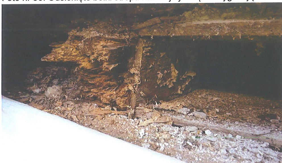
Foto nr 37. Odsłonięty strop najwyższej kondygnacji. Usunięte uszkodzone fragmenty belek stropu.
