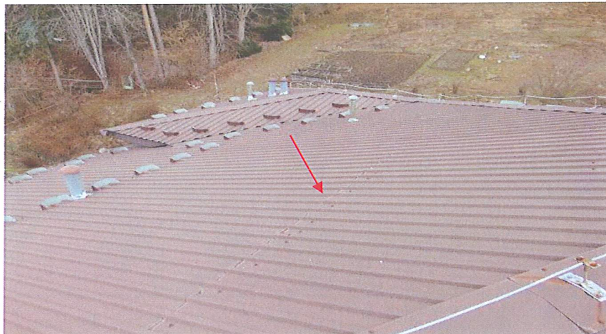
Foto nr 8. Fotografia dachu wykonana w 03.2019 r. Widok połaci w kierunku zachodnim. Styki poprzeczne blach. Potencjalne miejsce przecieków na deskowanie dachu.
