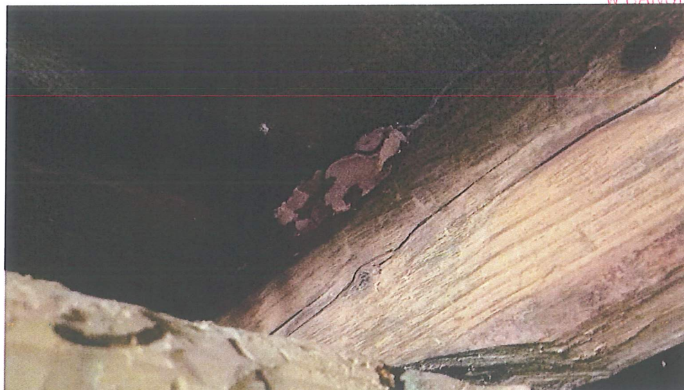
Foto nr 26. Przeciek wody przez pokrycie w obszarze paneli solarnych spowodował miejscową destrukcję objętości drewnianej krokwi i wzrost grzyba.
