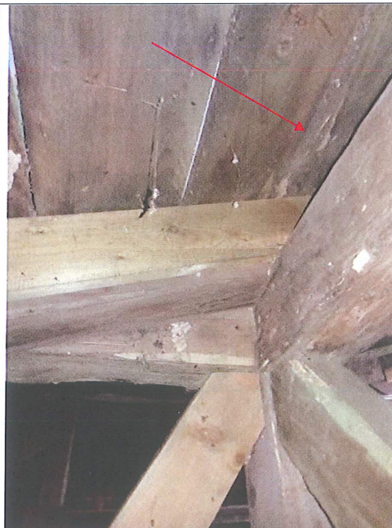
Foto nr 46. Deski o niskich parametrach wytrzymałościowych
