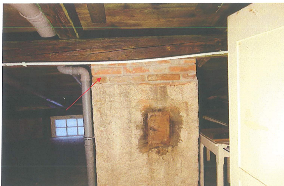
Foto nr 26. Wnętrze strychu. Komin K-3 . W minionych latach został przemurowany. Nowe fragmenty komina nie otynkowano.
