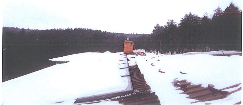
Foto nr 17. Widok dachu w stronę zachodnią. Komin K-1 z kotłowni. Komin murowany z przewodami: spalinowym i wentylacyjnym.
