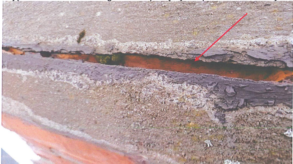
Foto nr 24. Uszkodzona pokrywa betonowa komina.
