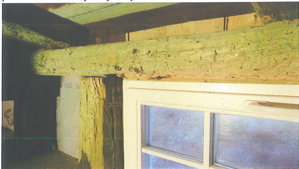
Foto nr 35. Uszkodzone belki i słupków ścianki kolankowej.
