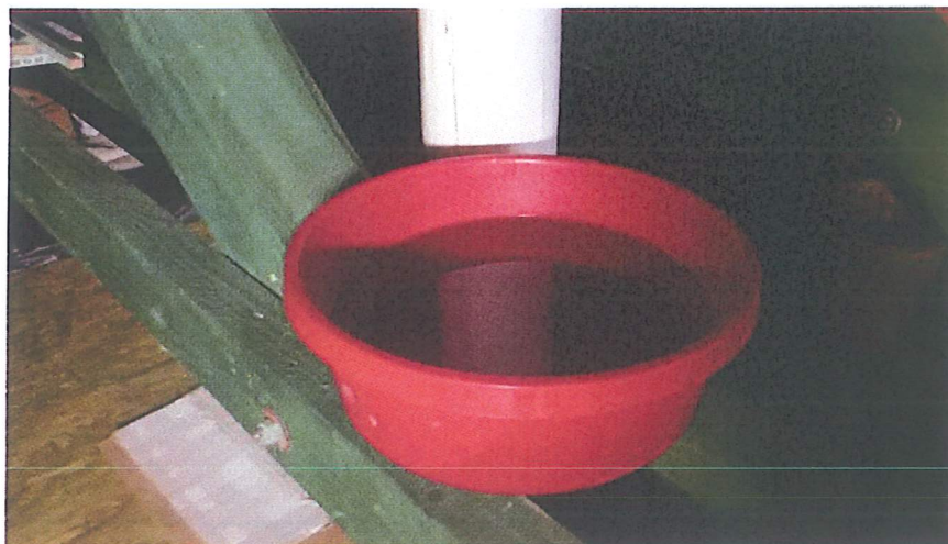
Foto nr 2. Intensywny przeciek wody przez pokrycie dachu.
