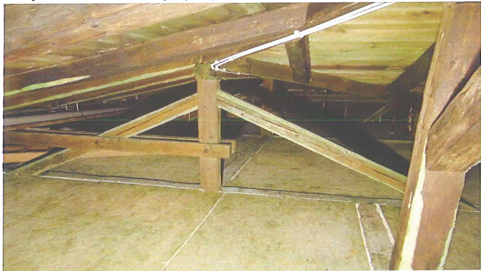
Foto nr 34. Uszkodzone belki. Oczyszczenie belek więźby dachowej z produktów destrukcji biotycznej.
