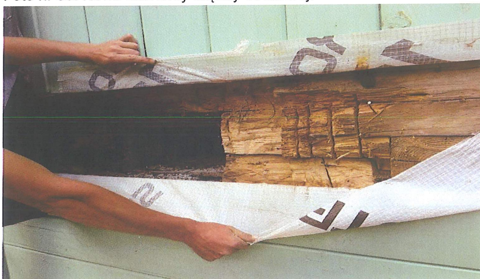
Foto nr 36. Odsłonięte belki stropu nad najwyższą kondygnacją.
