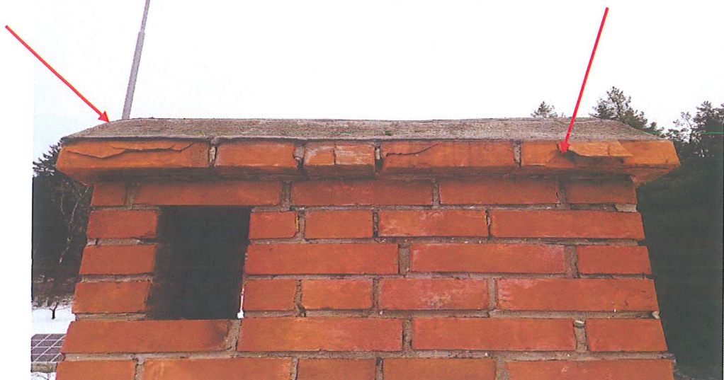
Foto nr 23. Komin z kuchni. Destrukcja pokrywy betonowej i cegieł w objętości. Brak metalowego okucia pokrywy lub powłok bitumicznych.
