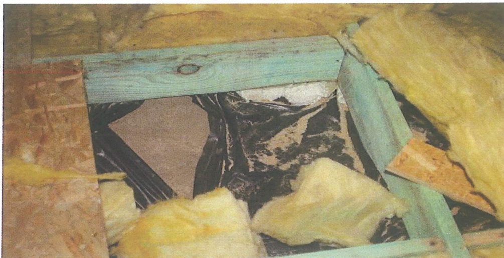
Foto nr 41. Otwarta górna płaszczyzna stropu nad najwyższą kondygnacją. Częściowo wymieniono ciężką polepę na wełnę mineralną, wykonano ruszt wspierający ślepą podłogę z płyt OSB.
